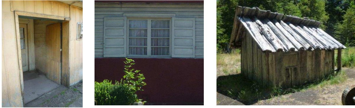
Fig. 1. Double door, Curacautín. Fig. 2. Shutters, Curacautín. Fig. 3 Interlocking timber cladding, Casa del Colono, Conguillio
