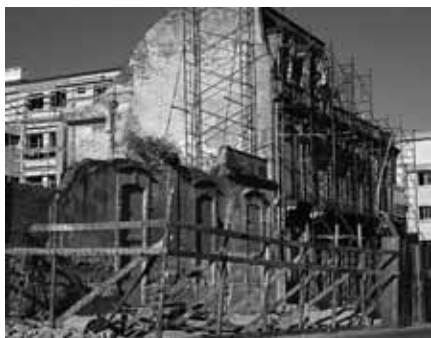
Figura 2 Conventillo Reus al Sur en Demolición. Foto: Blog Red de Turismo Comunitario Barrio Sur y Palermo
