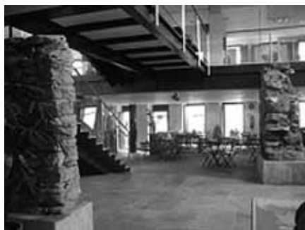
Figura 6. Pilares de alvenaria de pedra e ao fundo o café. O Centro Cultural e Turístico do Sistema FIEMG em Ouro Preto. Vanessa Regina Freitas da Silva. Acervo particular, 11 ago. 2009.
