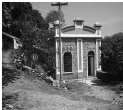
Figura 4: Antiga Usina de geração de energia. Fonte: CREMA, F. (2008).
