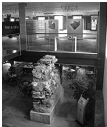
Figura 7. Alvenaria de pedra conjugada à estrutura metálica; vista do mezanino onde funciona a galeria de arte. O Centro Cultural e Turístico do Sistema FIEMG em Ouro Preto. Vanessa Regina Freitas da Silva. Acervo particular, 11 ago. 2009.
