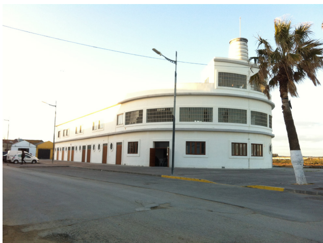
Fig. 6 Vista exterior antigua Lonja de Barbate.
