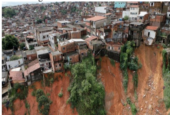
Fig. V – Deslizamento de Terra
