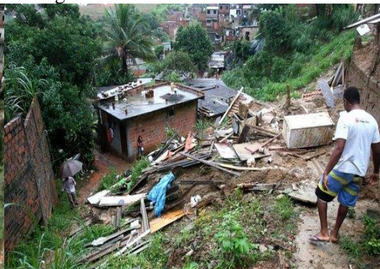
Fig. VI – Desabamento de imóvel
