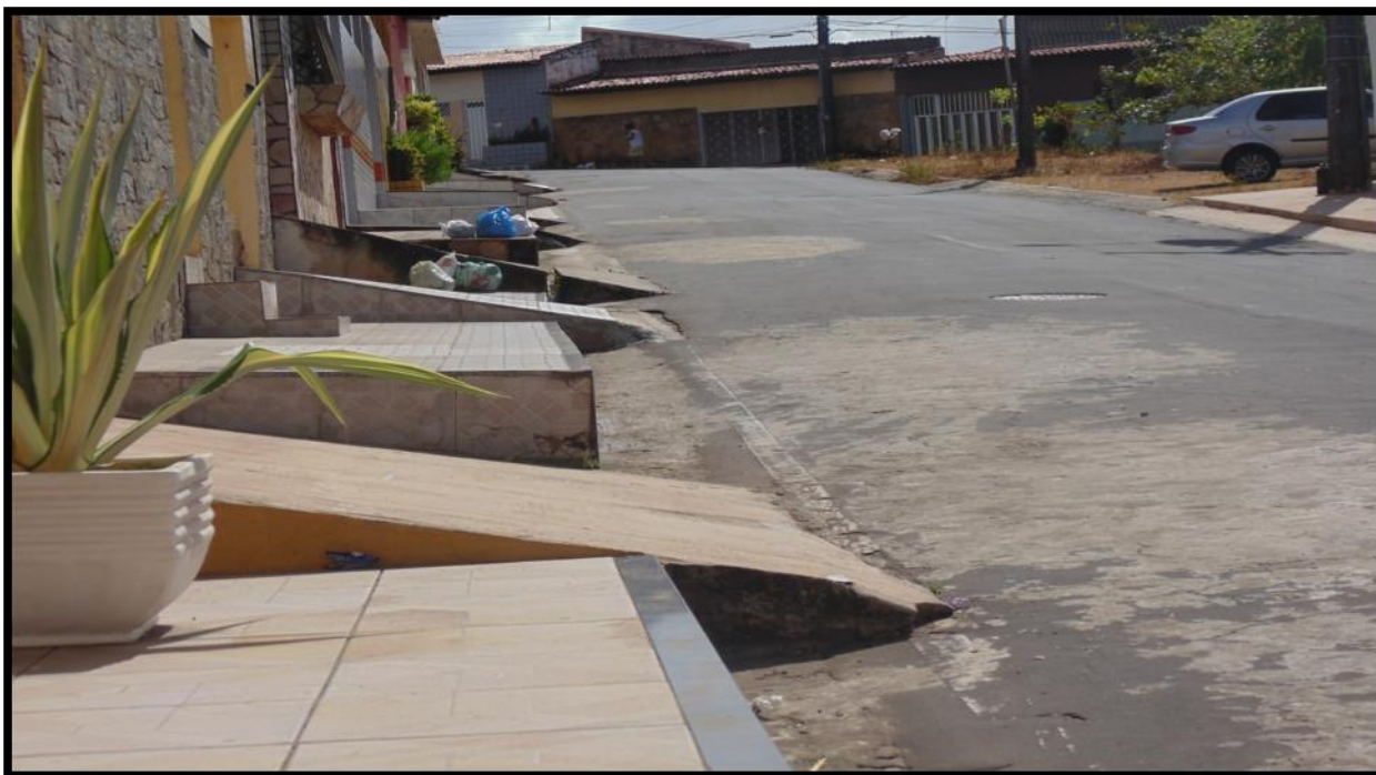
Foto 01: Calçadas desniveladas no conjunto habitacional Angelim
