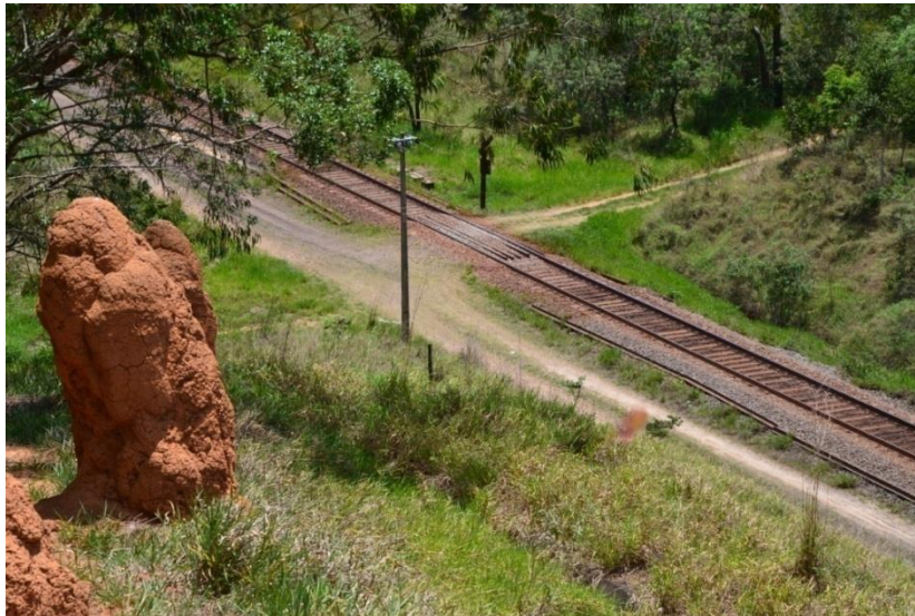
Figura 10: Passagem de Nível ferroviário na trilha da ferrovia.
