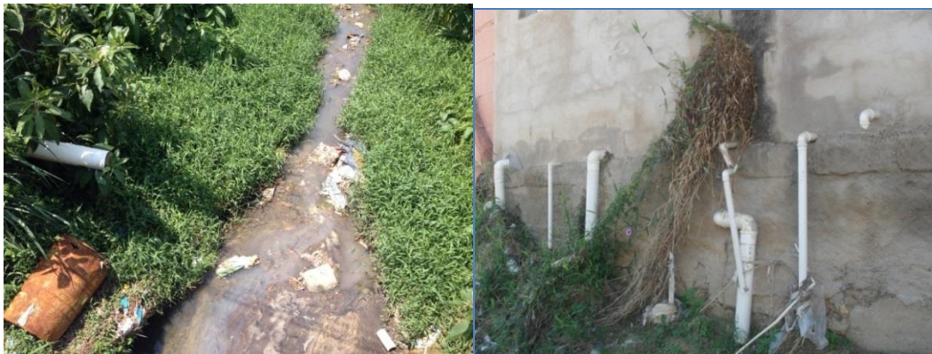
Figura 5: Esgoto in natura jogado no Córrego do Lenheiro
