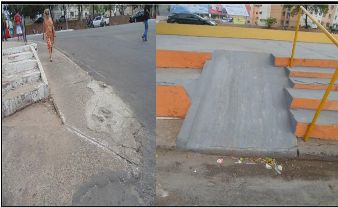
Foto 02: Rampas de acesso mal estruturadas no conjunto habitacional Angelim.
